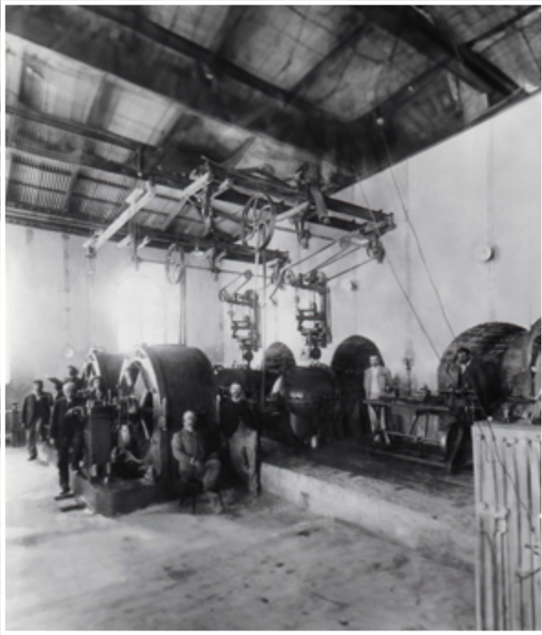
FOTO 1: Trabajadores de SEAL junto al dínamo trifásico y la turbina de Charcani.
